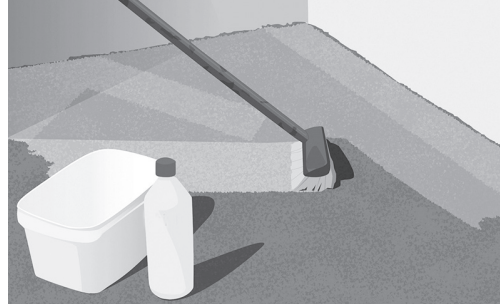
Fig. 3. Rengør og forbehandl gulvet
